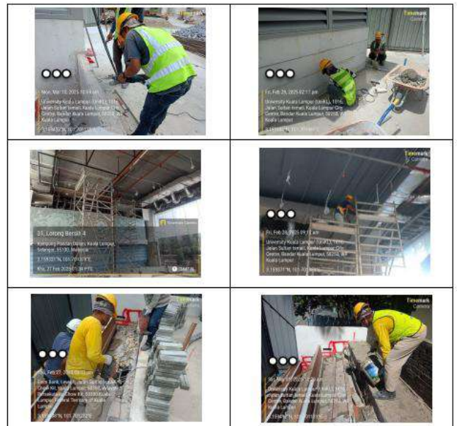
4. Kerja-kerja penyelenggaraan dan pembaikan unit penghawa dingin di bangunan searchct, kuala lumpur.
