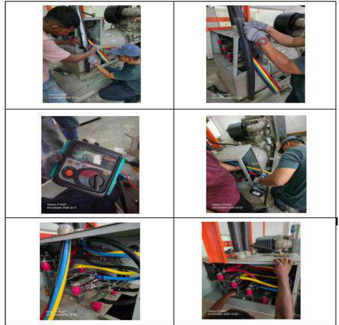
2. Kerja-kerja penyelenggaraan dan pembaikan genset (kabel) di Bumi Time.com di UPM Serdang.
